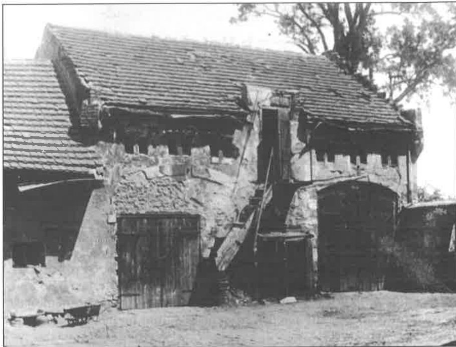
Obr. 1. Pohled do dvora statku ve starých Holešovicích: budova stodoly, kolny, sklepa a seníku. 20. léta 20.stol. Repro D. Havránková.
